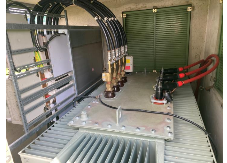
Lieferung und Montage eines Miettransformators durch uns um Ausfallzeiten (Ertrag) während der Traforeparatur zu minimieren. Außerdem wurden die MS-Seitigen Endverschlüsse durch uns getauscht.
