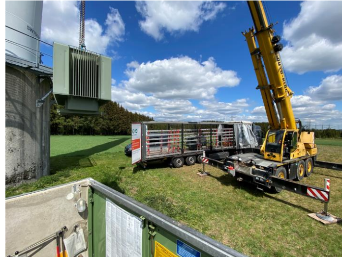
Tausch eines defekten Transformators gegen einen Miettransformator durch uns.
