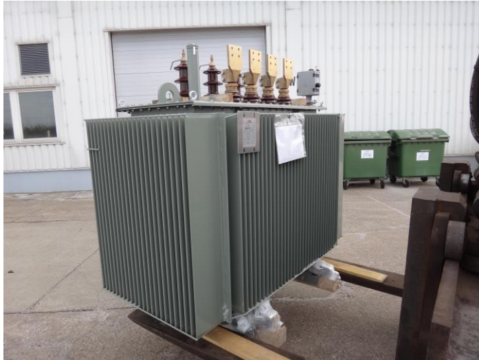
Lieferung und Montage von Neutransformatoren
